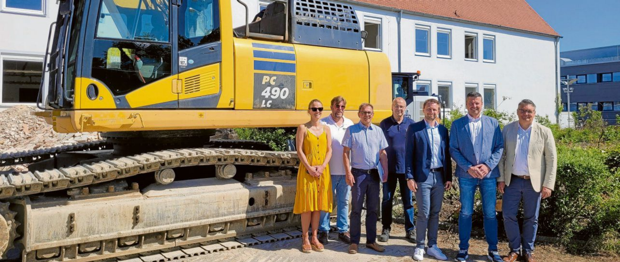
Der Bagger ist da, der Außenabbruch an der Grund- und Mittelschule Bäumenheim kann starten. Auf dem Bild zu sehen (v.l.n.r.): Sarah Kulartz, Florian Trinkl, Kurt Niebler, Dietmar Goll, Florian Mittler, Stephan Kreuzer und Peter Naumann. Fotos: Bill Titze
